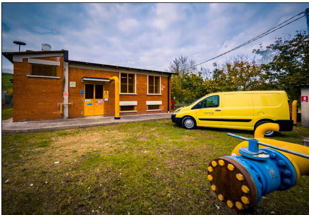
Esterno Cabina REMI (Regolazione e Misura)
