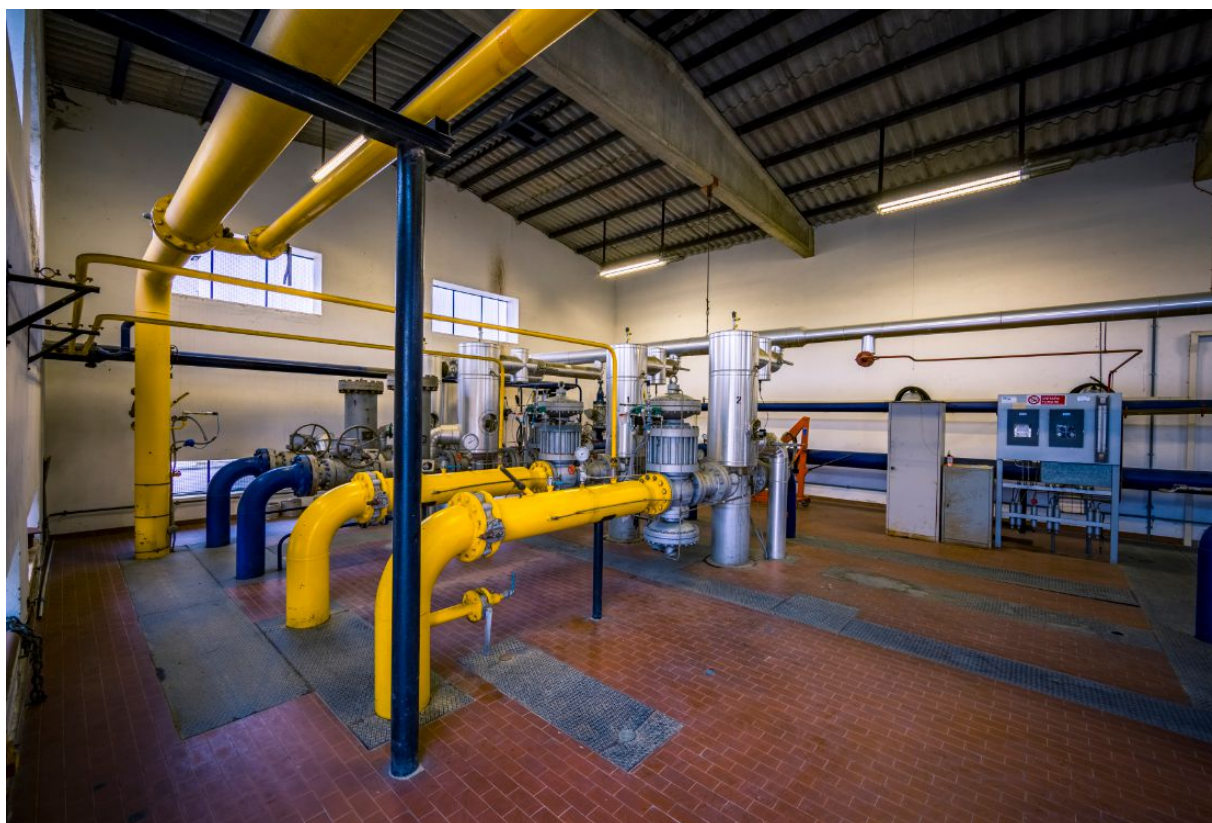
Cabina REMI (Regolazione e Misura)
